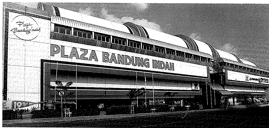
Pusat Perbelanjaan Yang Dikelola Oleh PT. Bhuwanatala Indah Permai
